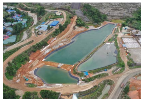
Hoàn thành lót chống thấm hồ TSF-SP
