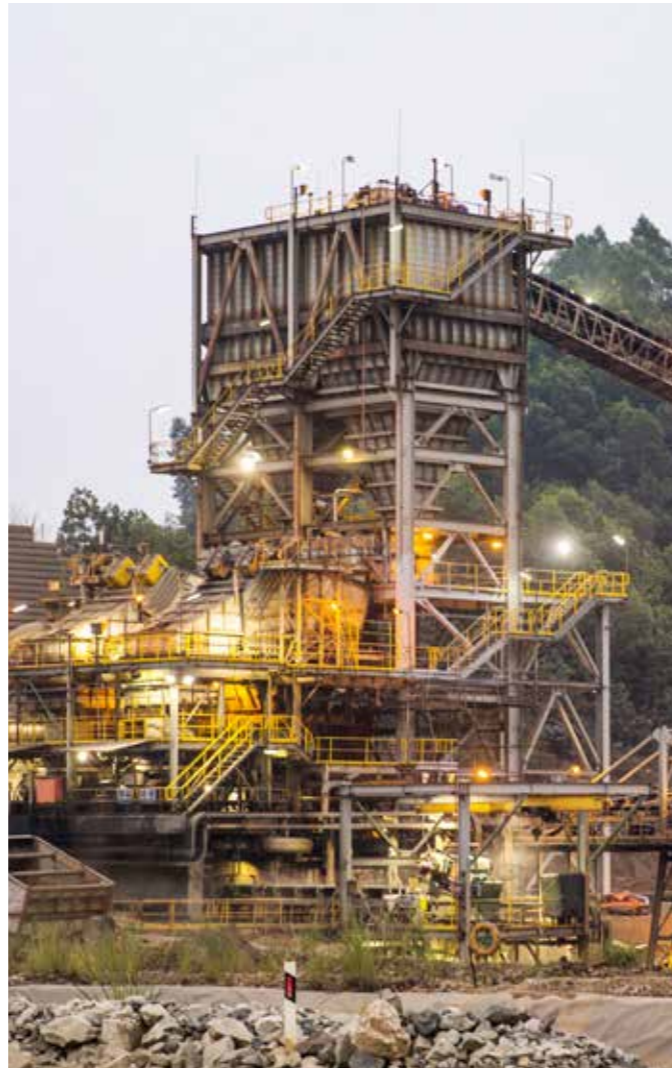
Khu vực Trạm nghiền NPMC tại Việt Nam
