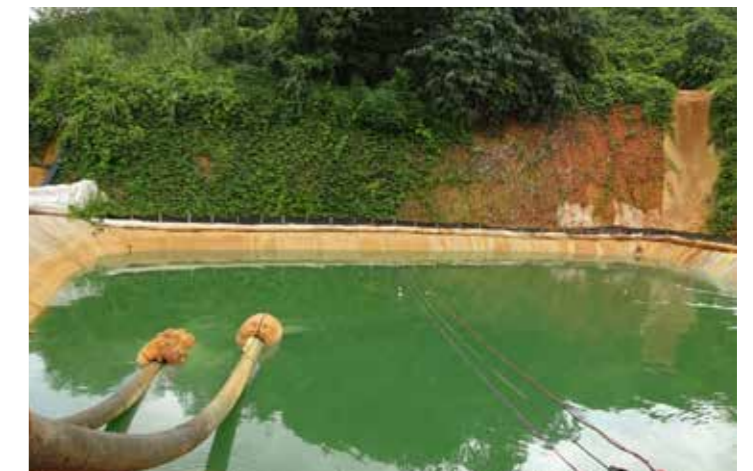
Hồ thu gom nước rỉ từ khu vực chứa quặng hàm lượng thấp
