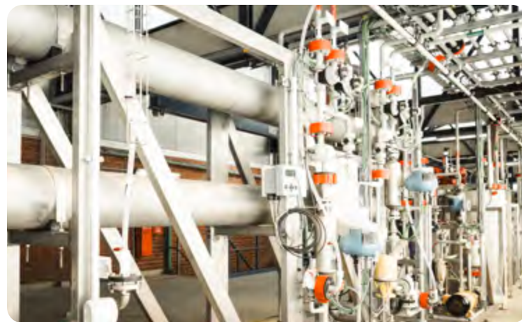
Thiết bị thẩm thấu ngược trong Nhà máy sản xuất AMT tại Goslar, Đức
